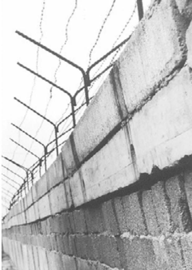
Abb. 1: Die Mauer (Potsdamer Platz/28. Juli 1962. Der ursprüngliche Bau ist um zwei weitere Lagen und die sogenannten Y-Abweiser aufgestockt, zwischen denen Stacheldraht befestigt ist). Quelle: Landesbildstelle Berlin.
